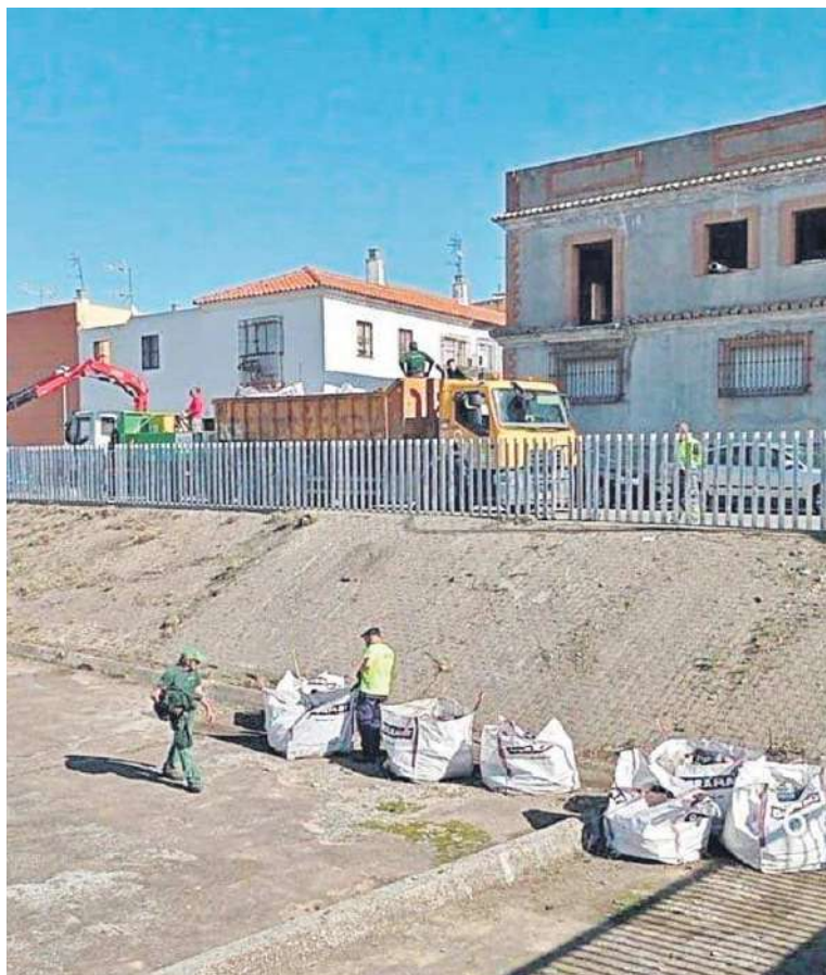
Obra de Emasesa en el canal de Palmete en 2024.
